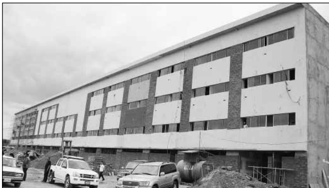
Así luce la que será la nueva sede de los Juzgados de Managua.
